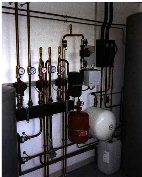
A droite, la pompe solaire et la régulation solaire. A gauche, le collecteur avec les pompes de chauffage et de charge du ballon d'eau chaude. La vanne d'inversion solaire/chauffage est placée en bas à côté de la bouteille de découplage.
